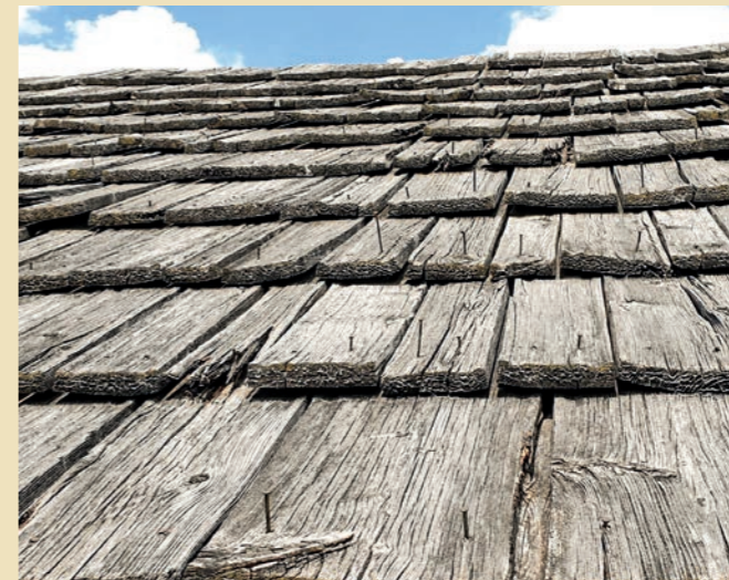
Die Nägel wurden von der Sonne herausgetrieben, die Bretter lösen sich langsam auf
