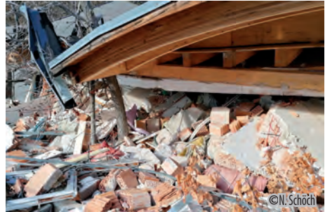
Ein Felssturz traf 2021 einen Hotelkomplex oberhalb von Bozen; wegen des Ruhetages kamen keine Menschen zu Schaden
